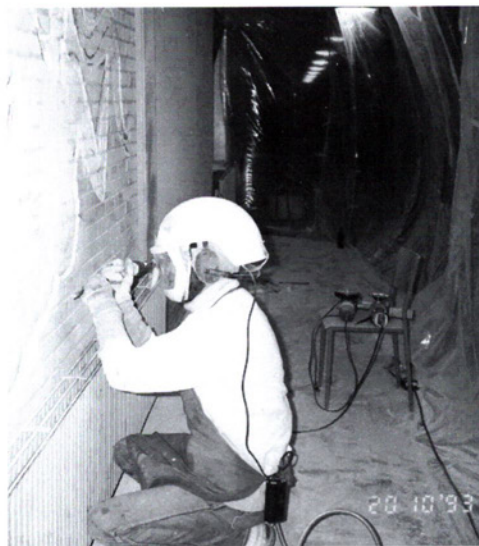
Det er ikke Storebælts-tunnelen, men det lugter lidt af vand. Havfruen er ved at bryde frem fra muren, hjulpet på vej af skulptør Steen Krarup Jensen og en trykluft-mejsel.
